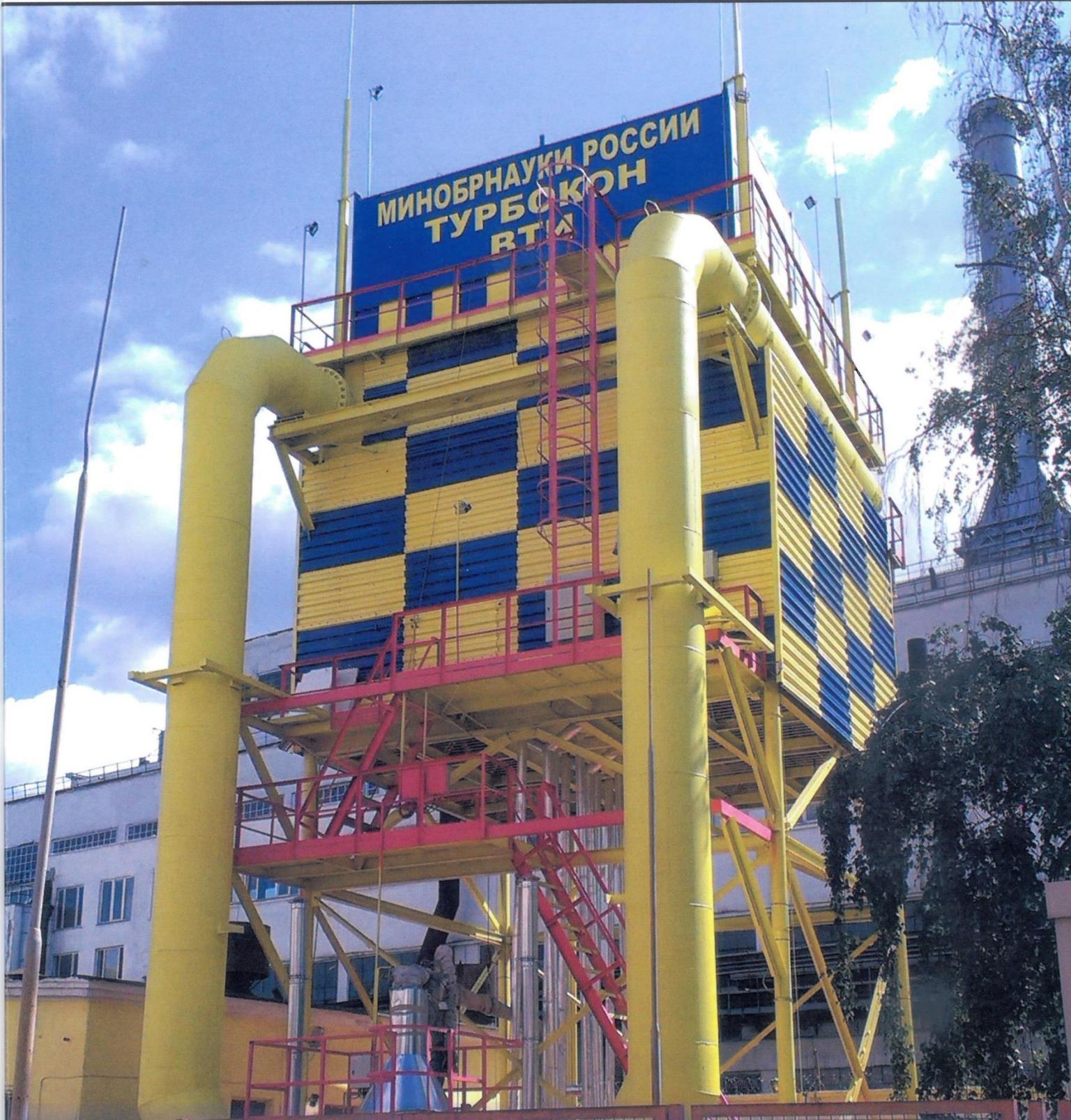
**Энергоэффективная секция воздушного конденсатора.
